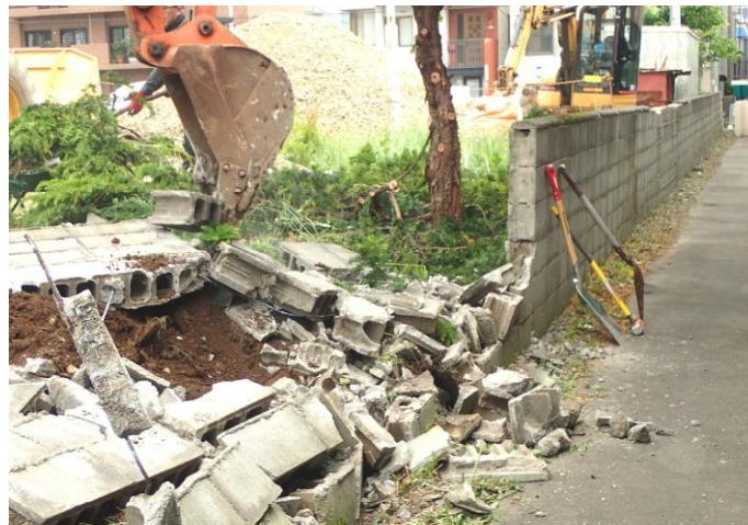
まずは危険箇所を解体。
