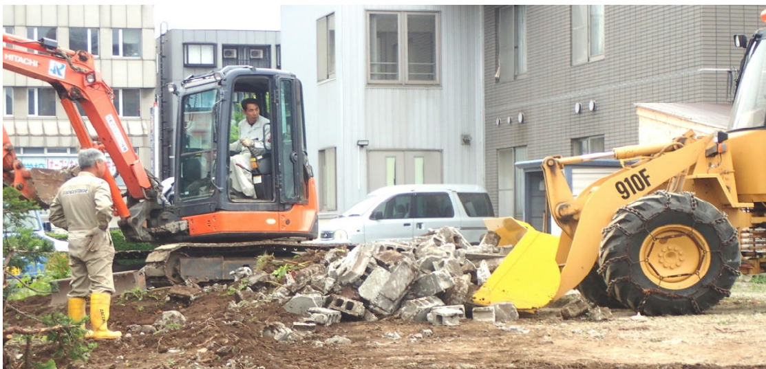
解体したブロックを集積し、整地を行う。
